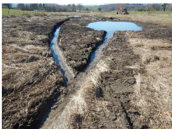
Creusement de mare et réorientation des écoulements, mars 2021
